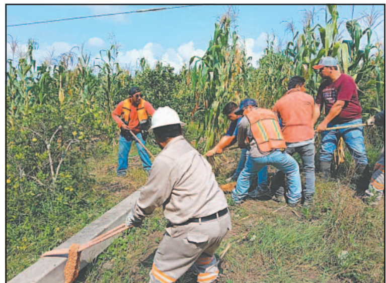
Trabajadores de la CFE restablecieron el servicio eléctrico en un 98.7%.
