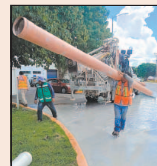
Los trabajos ayudarán a la filtración del agua en la zona.
