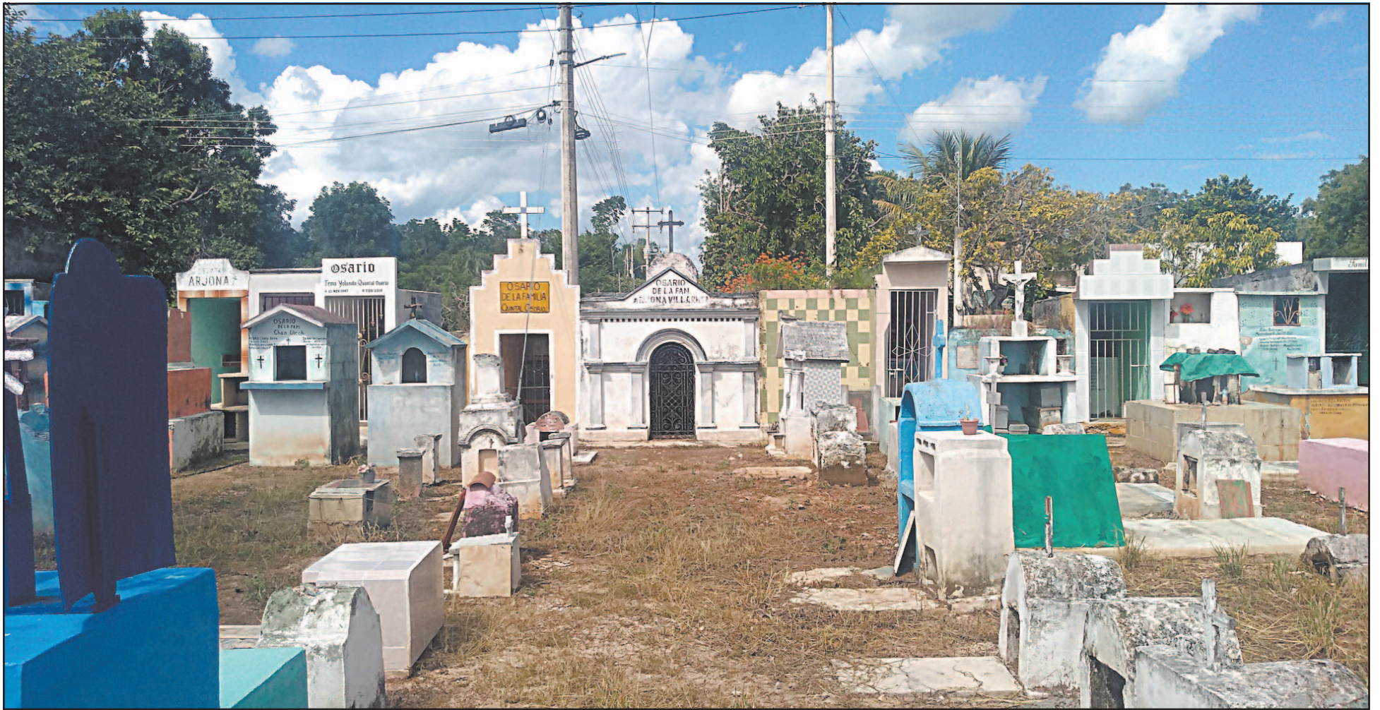
Cuadrillas trabajan a marchas forzadas para restaurar fachadas, la capilla y hasta la frases que no son visibles en las tumbas de los fallecidos. (J. Borges Castillo)
