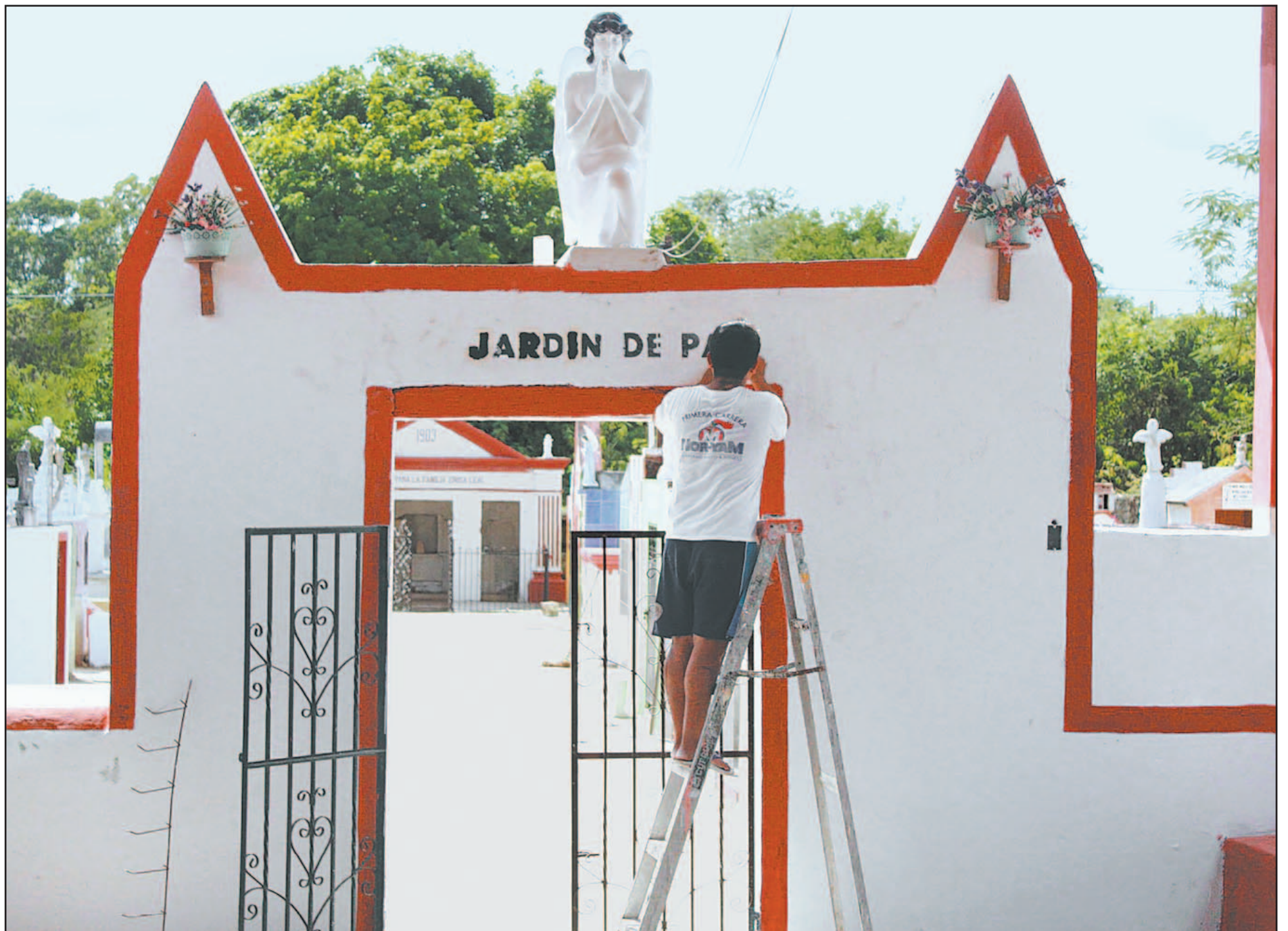
Cuadrillas de Dzitás trabajan a marchas forzadas en restaurar fachadas, la capilla y hasta la frase "Jardín de Paz", tallada en el acceso principal del panteón. (J. Borges)
