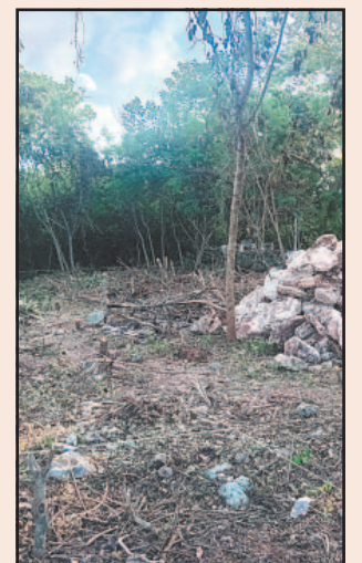
El terreno está siendo limpiado para los trabajos.
