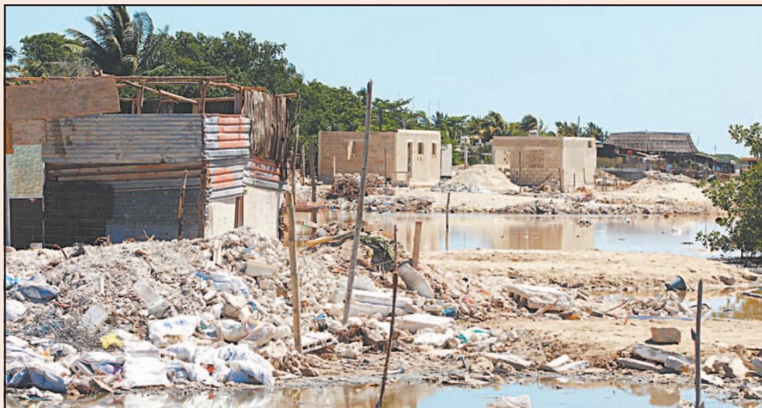
Estos trabajos afectan directamente la circulación del agua, privando a los mangles del líquido.
