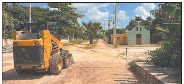
Con maquinaria pesada, los trabajadores repavimentan la calle 41.
