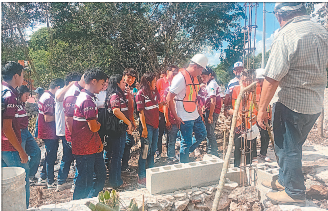
El acto simbólico marcó el inicio de la construcción de instalaciones para la impartición de clases.
