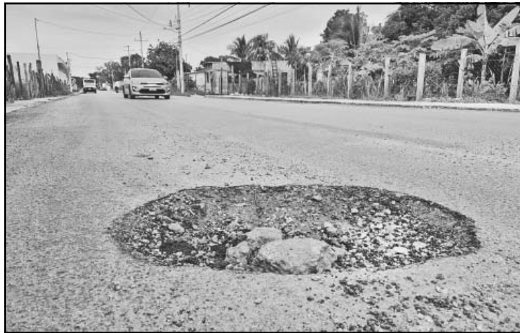
Se usó material de mala calidad en la reciente reparación. (Jorge M.)
