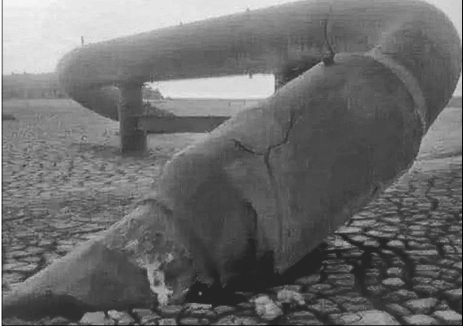
Pobladores temen una tragedia ante el deterioro de las tuberías con casi 50 años sin mantenimiento adecuado. (Perla Prado Gallegos)
