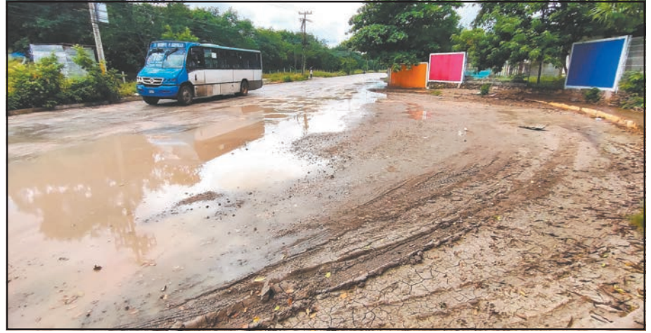
Hay un pozo de absorción que dejó de funcionar, lo que frena el paso de los coches.
