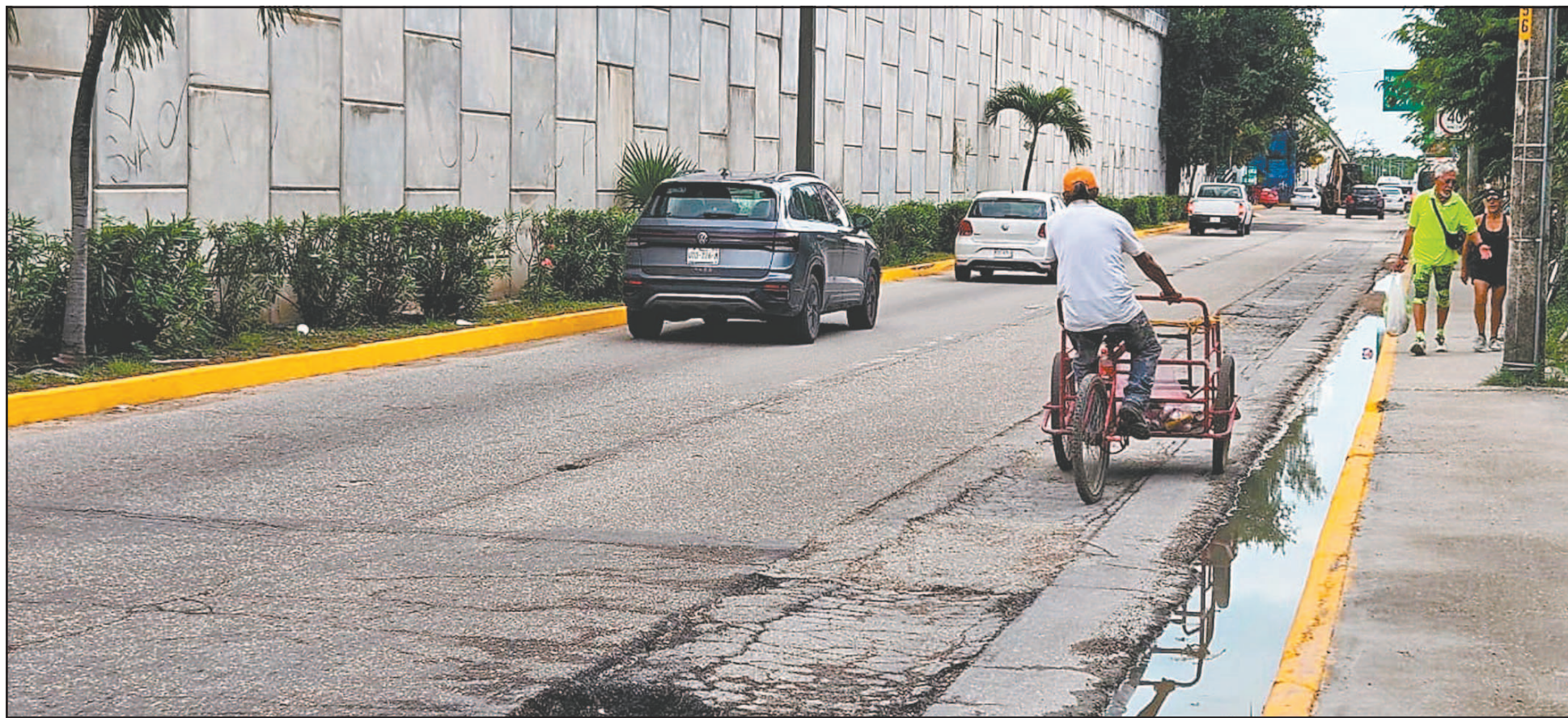
La cinta asfáltica está en mal estado desde hace años, luego de que se realizara la introducción de infraestructura del vital líquido y aunque fue reparada, se volvió a estropear. (G. Alcocer)
