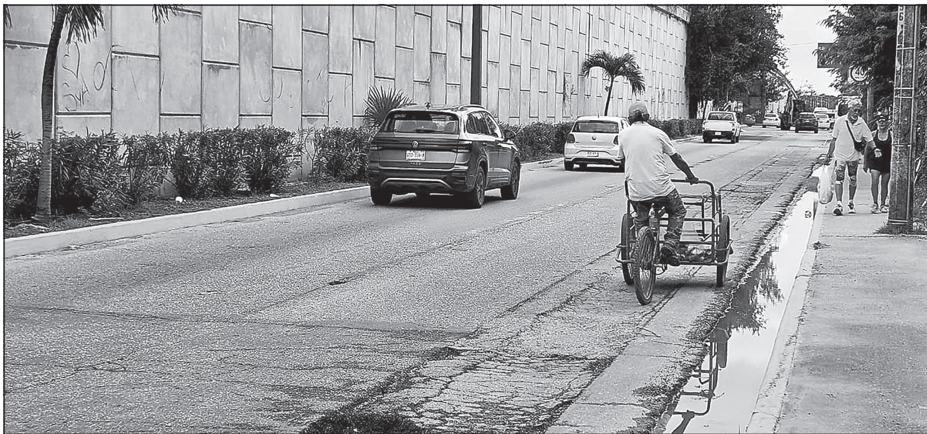
La cinta asfáltica está en mal estado desde hace años, luego de que se realizara la introducción de infraestructura del vital líquido y aunque fue reparada, se volvió a estropear. (G. Alcocer)
