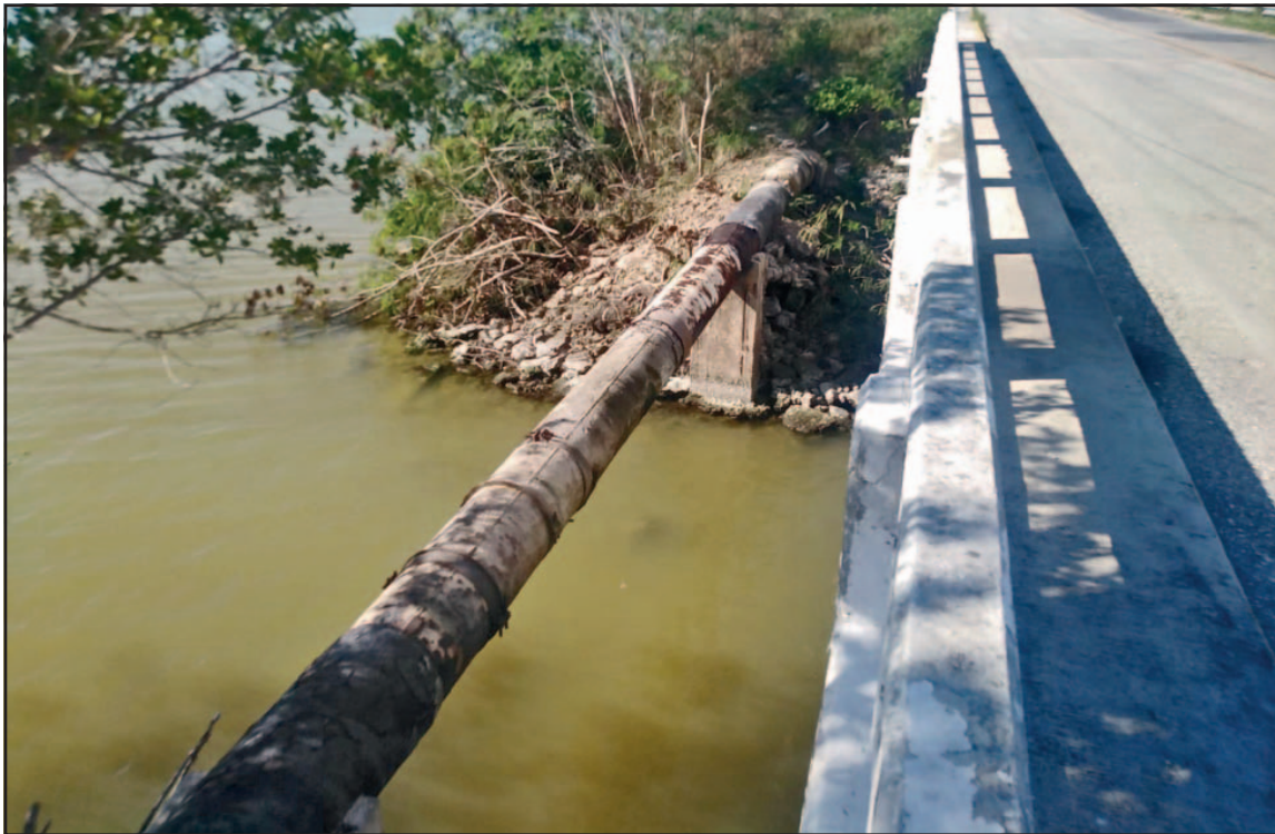
Existen algunos tramos donde la tubería ya no es funcional por la corrosión y el óxido. (Pedro Díaz)
