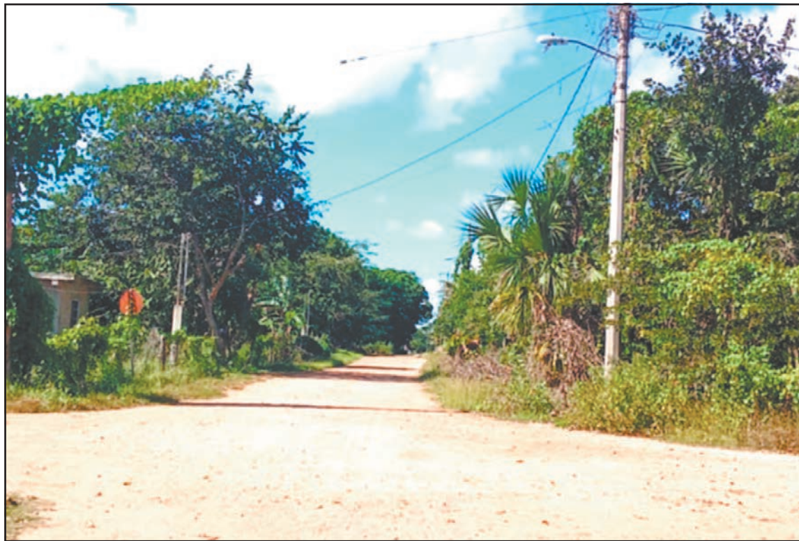
Ciudadanos aseguraron que el alumbrado no enciende desde las pasadas lluvias. (Enrique Cauch)
