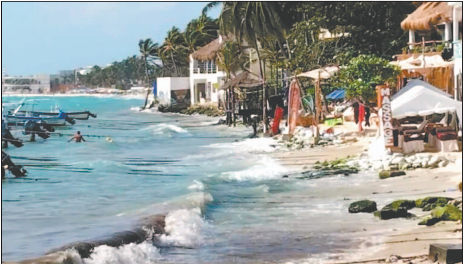
A nivel local se perdieron hasta 30 metros de arenales desde el 2020, debido a los temporales y la elevación del mar. (POR ESTO!)
