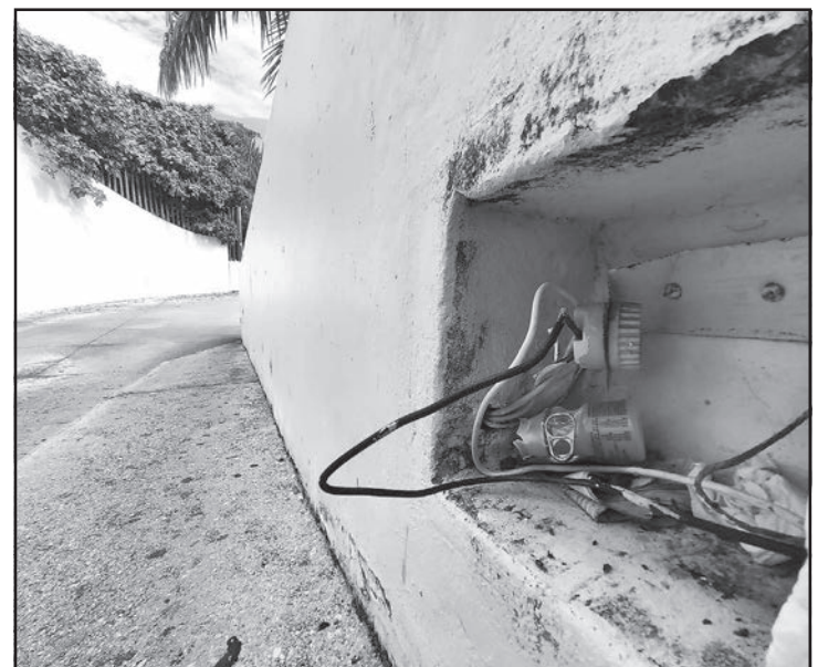
Se constató cableado suelto en un nosocomio. (Mario Hernández)
