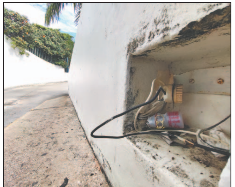
Se constató cableado suelto en un nosocomio. (Mario Hernández)
