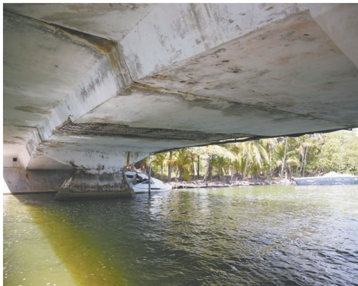
Desde abajo se pueden apreciar las vigas de hierro al descubierto.
