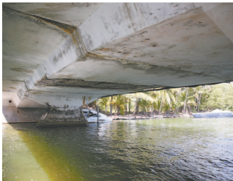
Desde abajo se pueden apreciar las vigas de hierro al descubierto.
