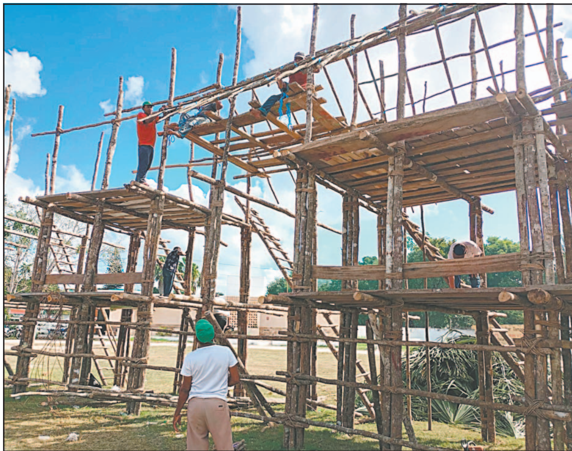
Sólo faltan los recubrimientos de los palcos, el techado de huano del tercer nivel y la colocación de celosías.
