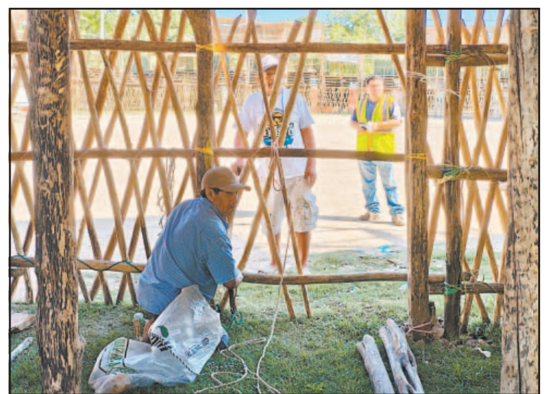
Revisaron el uso de maderas adecuadas y la firmeza de los amarres.
