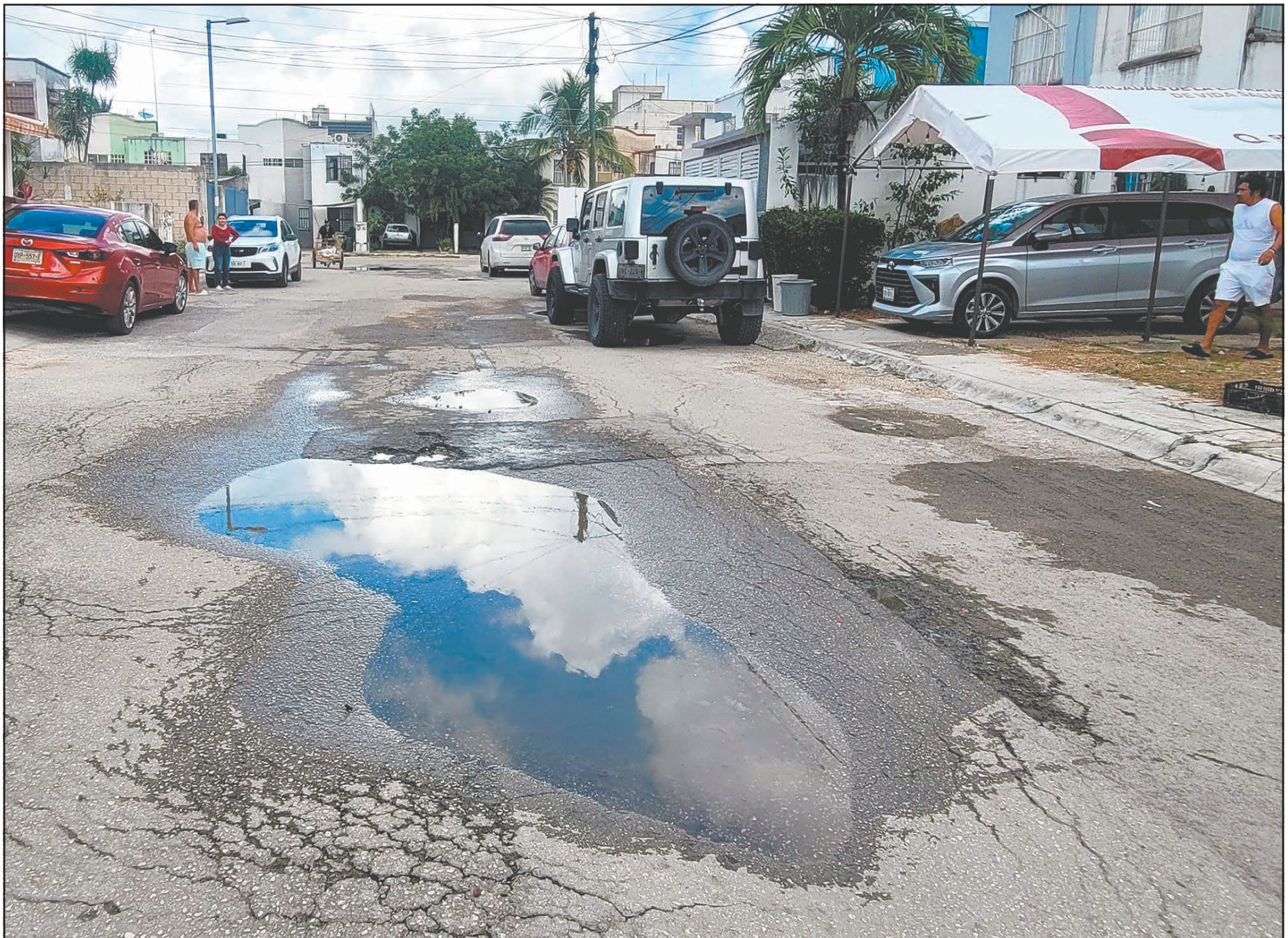
Daños visibles sobre la calle Raya Caculhá muestran hundimientos ocasionados por la presión constante del agua que brota desde la red, sin atención adecuada. (L. Vera)
