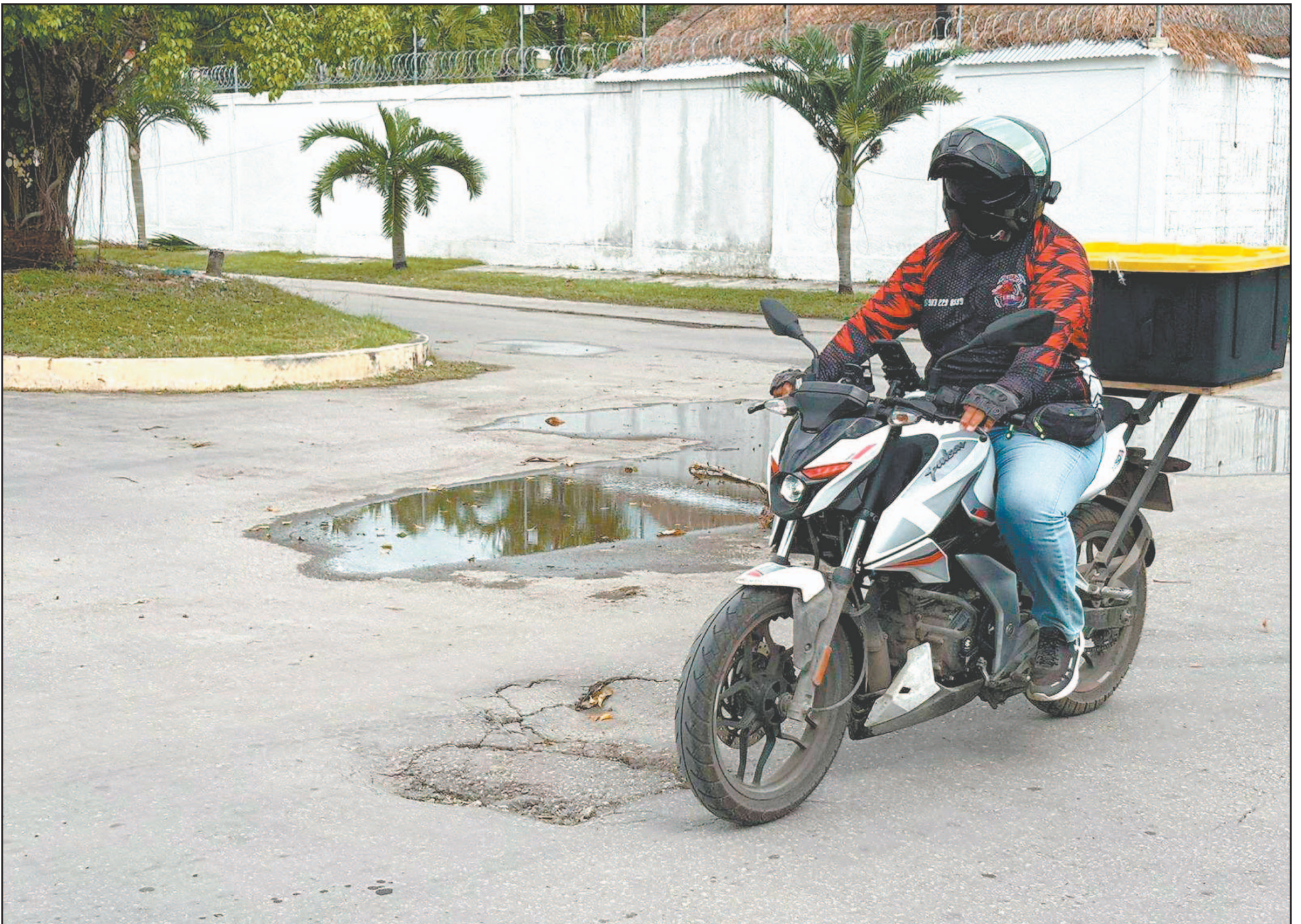
Baches rellenados con grava por los vecinos y maleza que invade las banquetas evidencian la falta de mantenimiento en la infraestructura vial, en Chetumal. (W. Duran)
