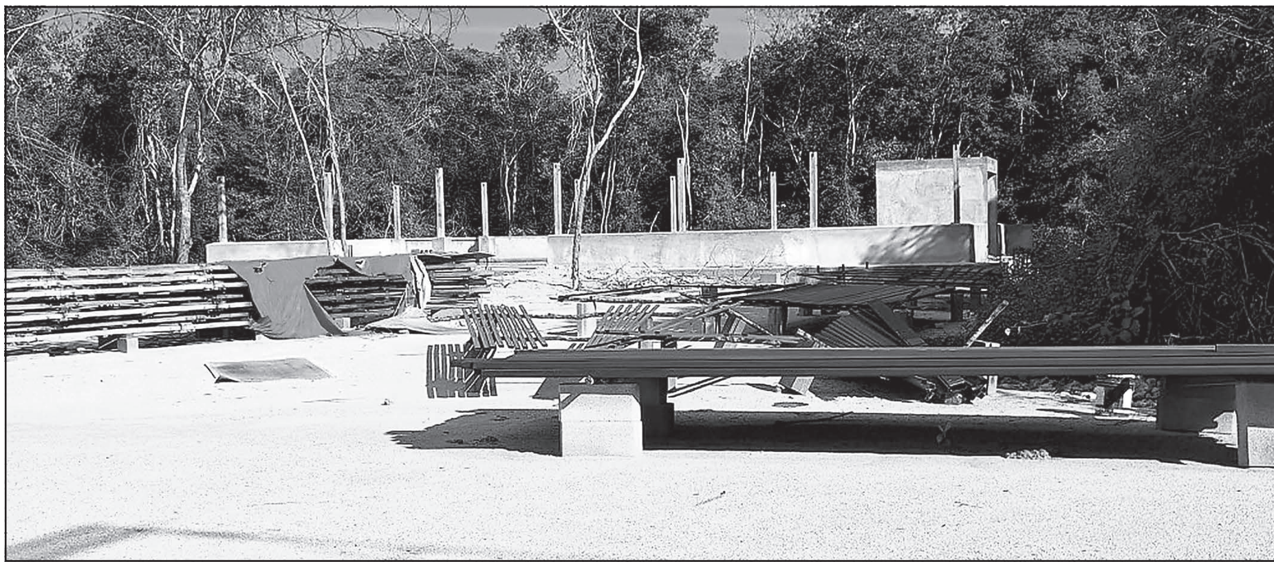
Descubrieron que la constructora no estaba identificada por su razón social, usaba madera como columnas y debían ser de concreto para soportar la estructura de la nave. (L. Kauil)
