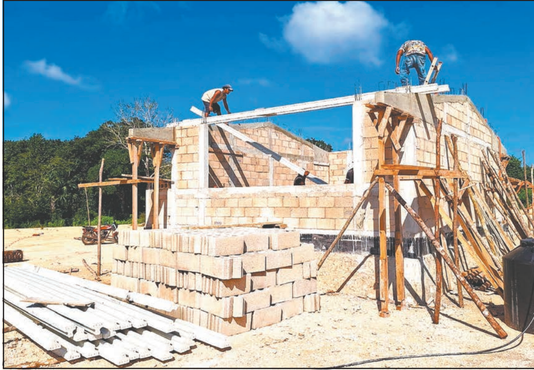
Informaron que actualmente el proyecto está en la colocación de viguetas y bovedillas para el techo. (J. Xiu)
