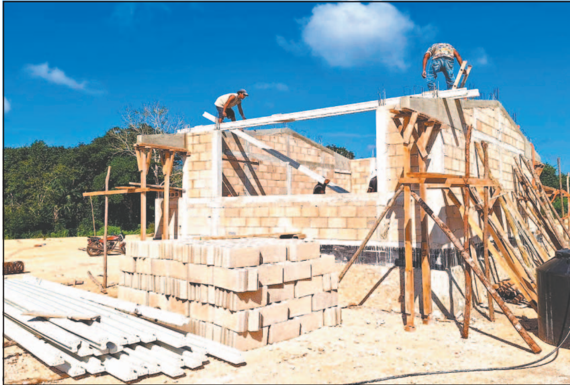
Informaron que actualmente el proyecto está en la colocación de viguetas y bovedillas para el techo. (J. Xiu)
