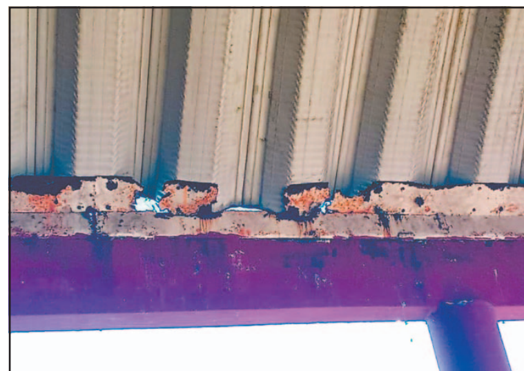
La corrosión en el techo del domo pone en riesgo a asistentes. (E. Cauch)
