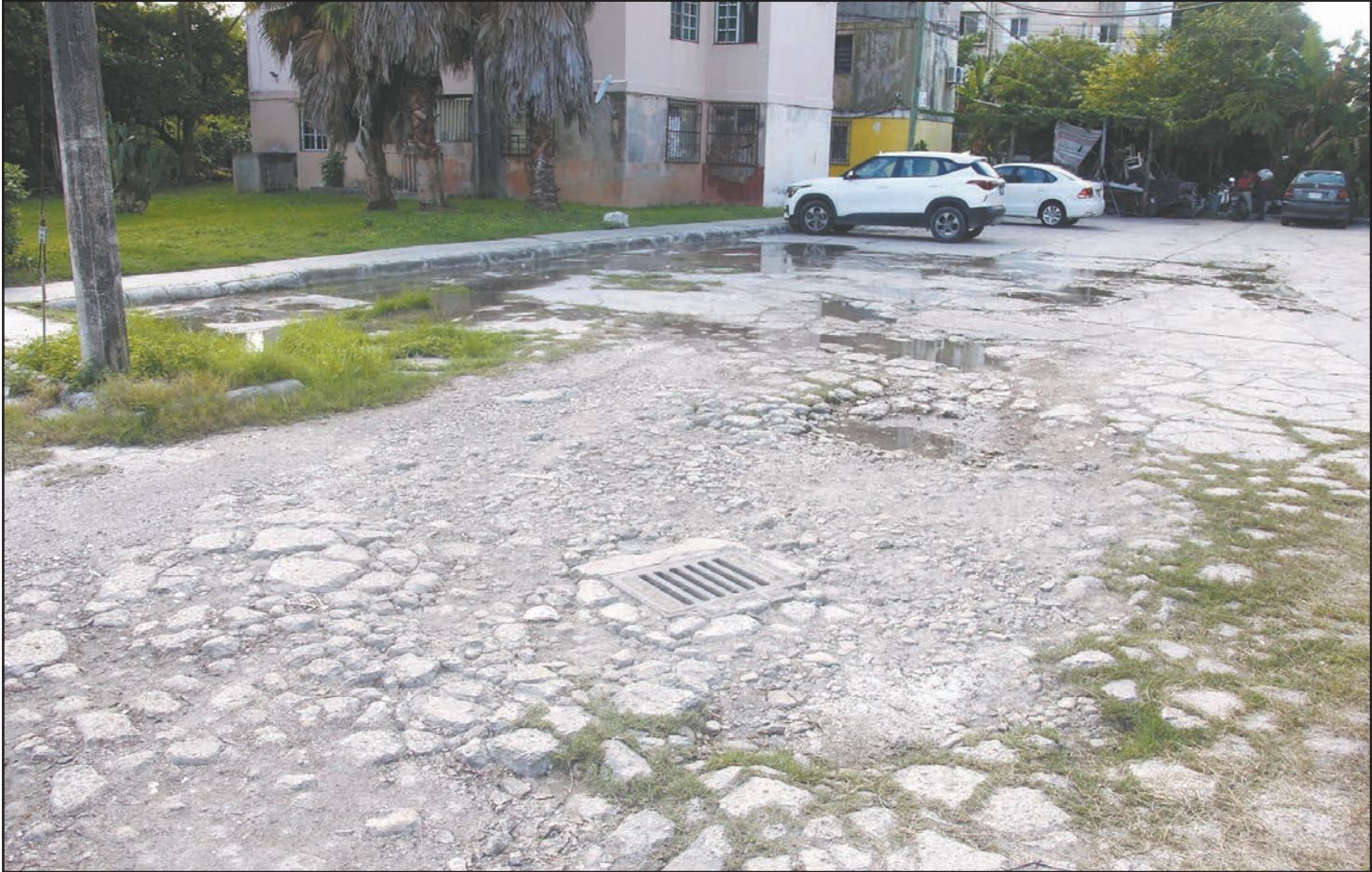
El asfalto envejecido y los socavones, de hasta metro y medio, obligan a conductores a maniobrar para evitar averías. (Liza Vera)
