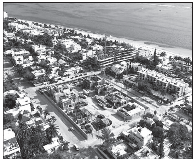
Adulto mayor exigió aplicar la ley de construcción en Villas 1. (PorEsto!)
