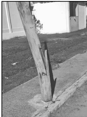
La estructura se sostiene por los cables; lleva meses dañada.
