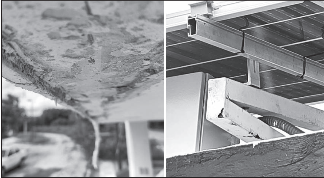
En el kilómetro 25 la estructura comienza a desprenderse y tiene óxido la base de los paneles. (Fotos M. Hernández)
