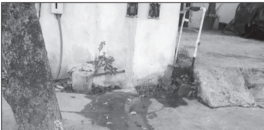
Redes obsoletas derivaron en fugas masivas, conducción deficiente y escaso caudal.
