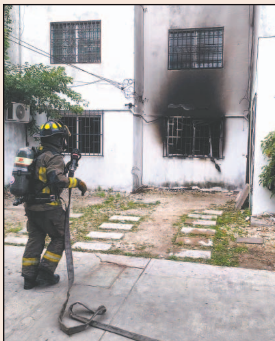
Al arribar, los bomberos detectaron que una ventana estalló por la radiación térmica. (Fotos G. Alcocer)
