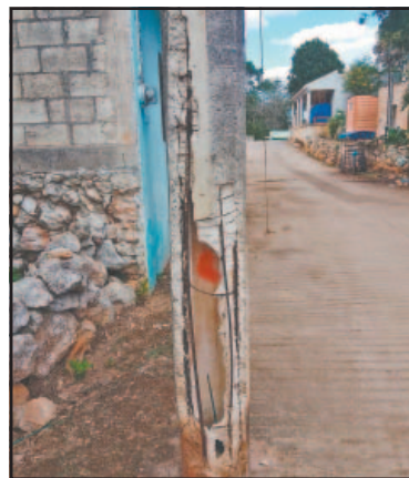
Al menos siete estructuras presentan varillas expuestas. (Especial)
