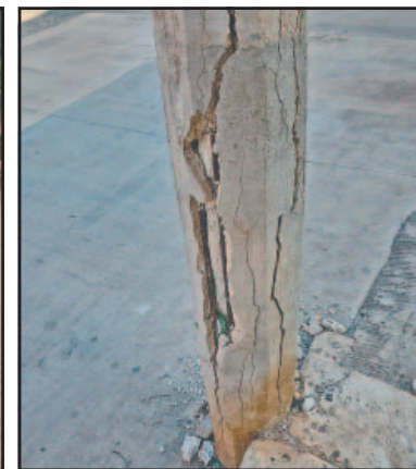
Al menos siete estructuras presentan varillas expuestas. (Especial)
