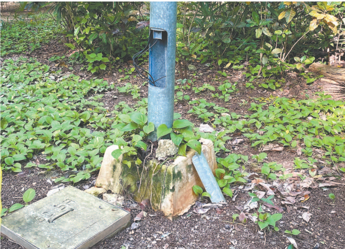
Por lo menos cinco puntos con cables sueltos del sistema de iluminación fueron detectados.
