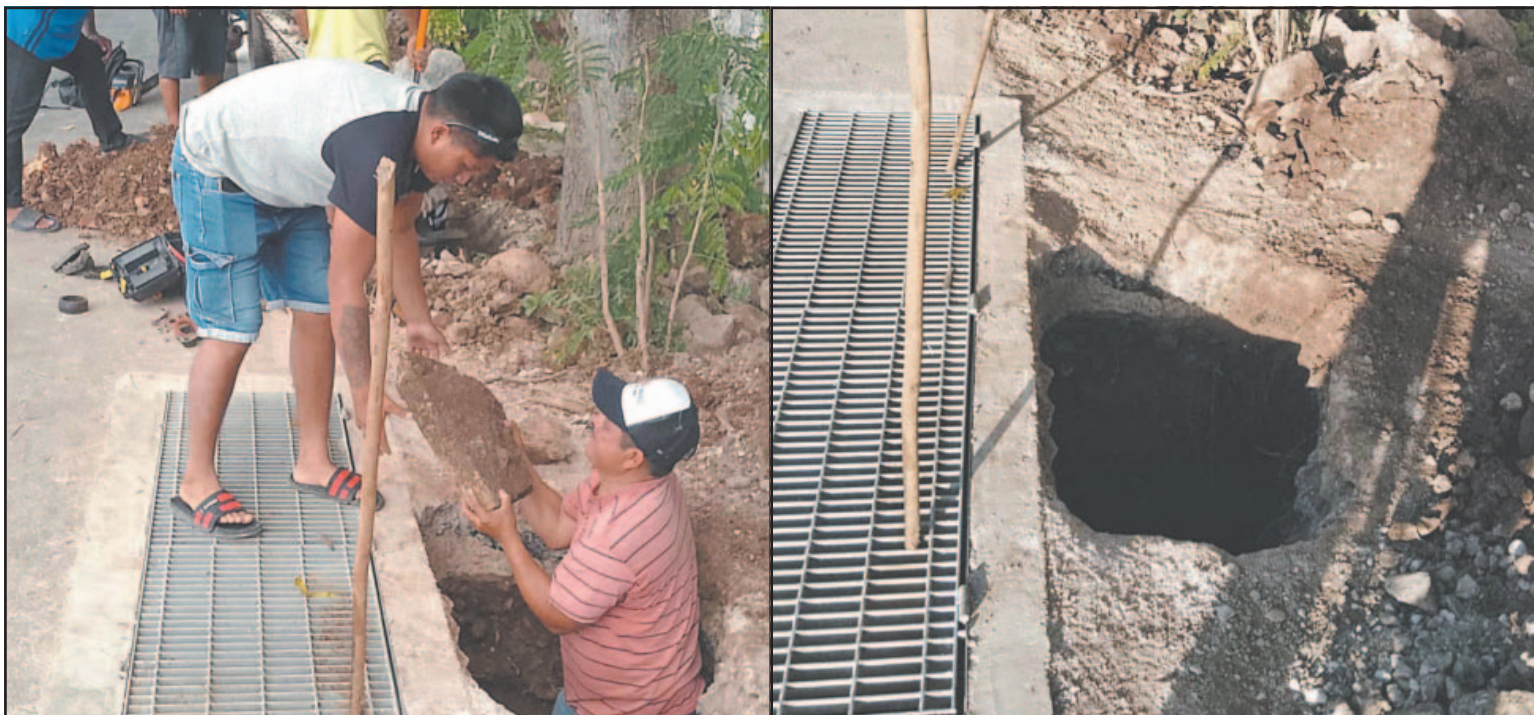
El daño a la estructura fue provocado por la intrusión agresiva de las raíces de un árbol que se encuentra en el camellón adyacente.
