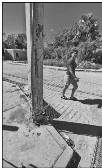
Las varillas sobresalen de la base de la estructura. (M. Koh)
