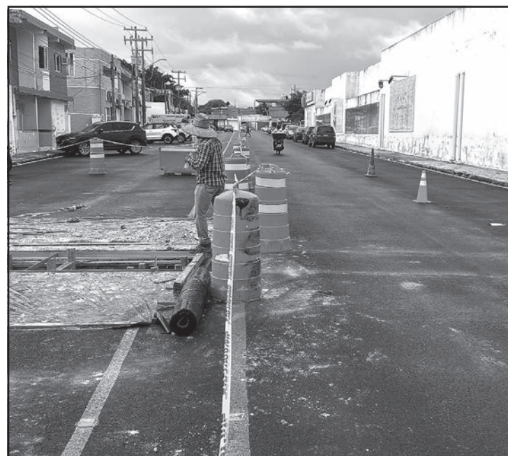
Rompieron el asfalto para trabajar en la red hidráulica. (E. Martín)
