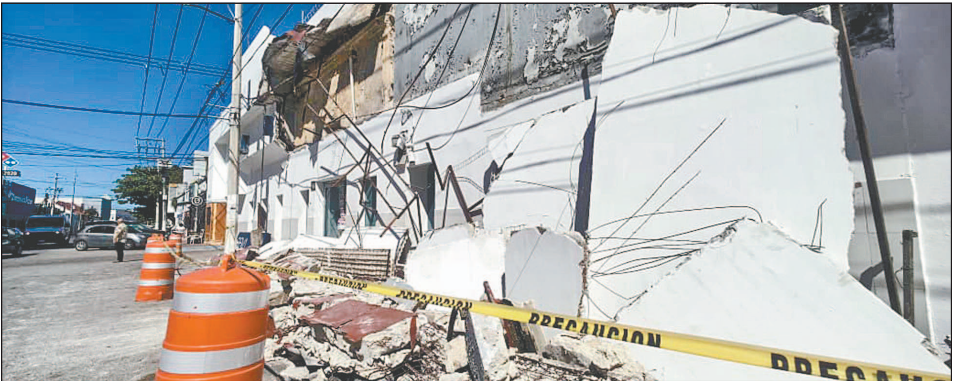
El análisis de la estructura permitirá conocer si la marquesina colapsada era la original del edificio o se anexó para homologar la imagen de la institución bancaria. (P.Prado)
