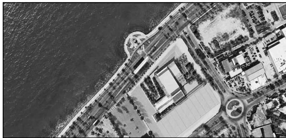
El área será delimitada con un tapiado durante el desarrollo de la obra. (POR ESTO!)
