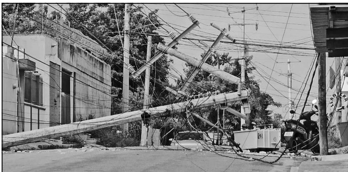
La estructura de concreto terminó atravesada en la calle y el transformador destruido. (Dismar Herrera)
