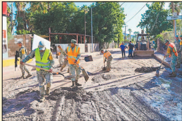
En BCS se mantienen labores de limpieza y rehabilitación.
