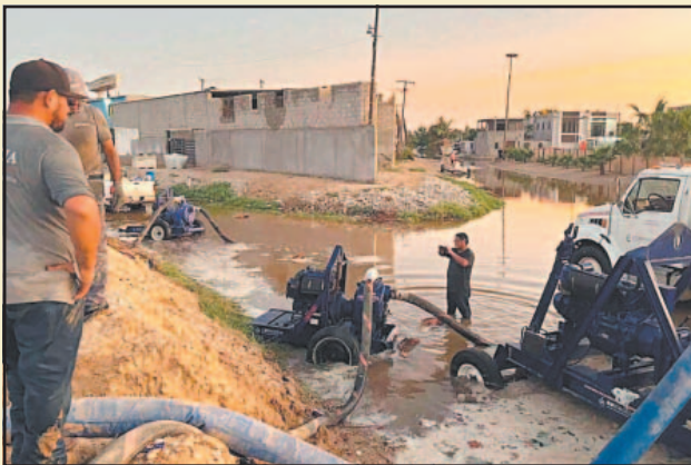
En el municipio de Comondú se realizan labores de desagüe.
