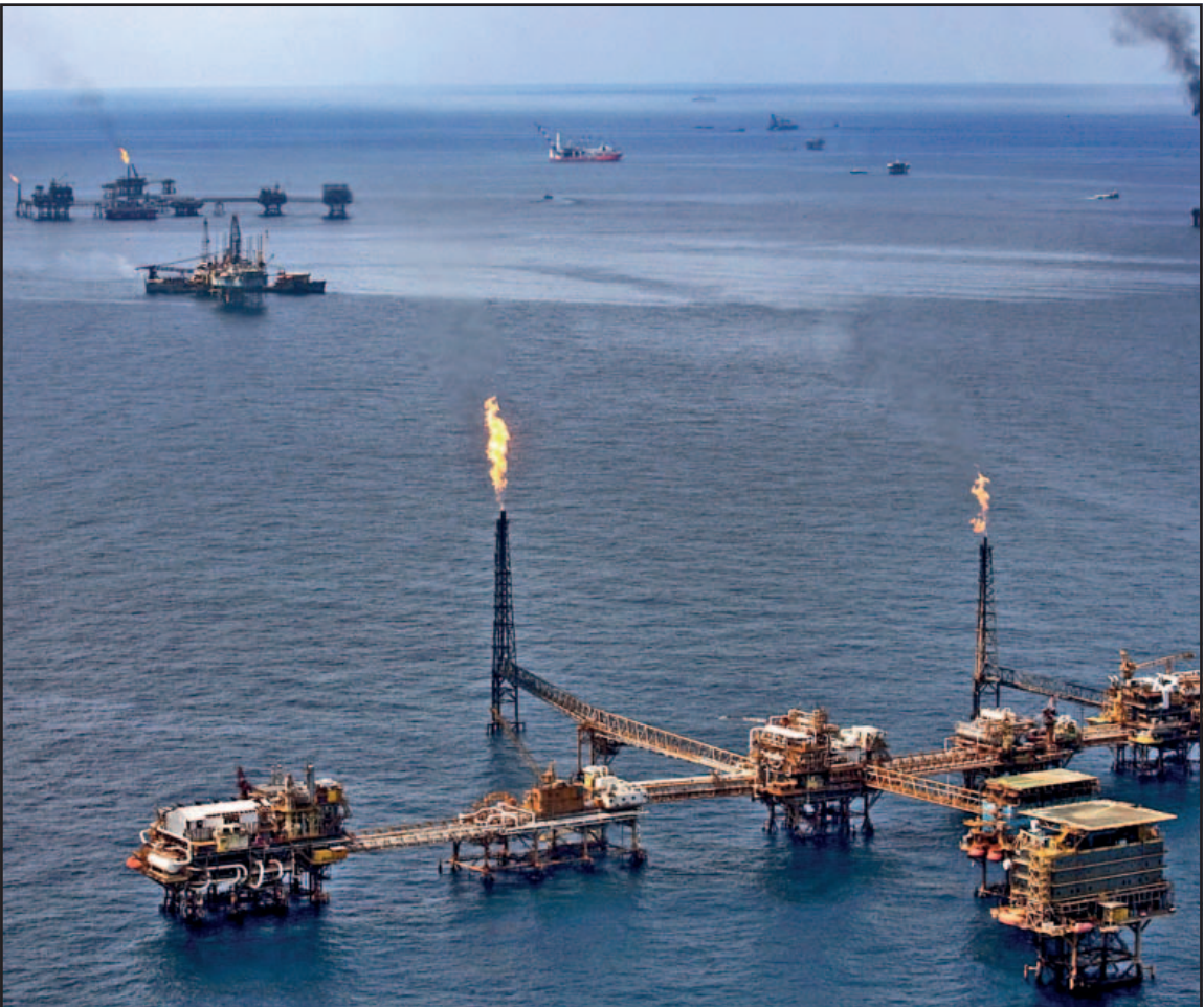
La fuga de petróleo fue detectada en las inmediaciones del complejo de plataformas Abkatún . (Especial)
