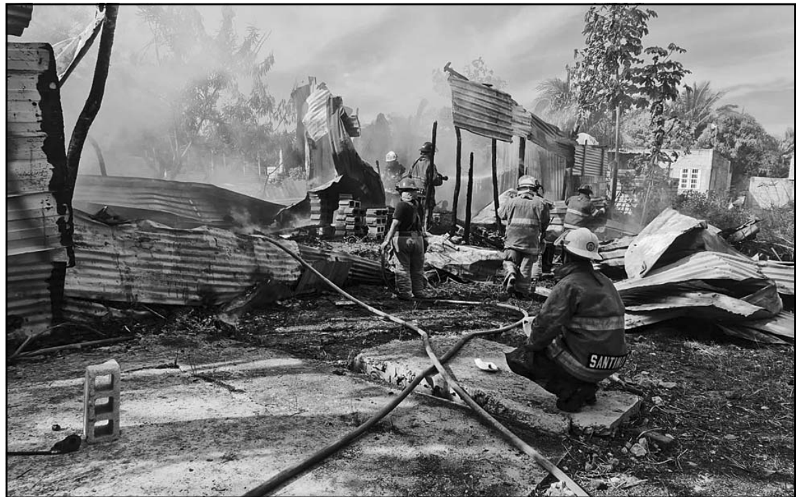
El inmueble quedó como pérdida total; los bomberos no se retiraron hasta que quedó todo apagado.
