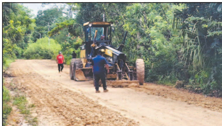
La entrada a la colonia quedó en pésimo estado por las lluvias. (L. Kauil)
