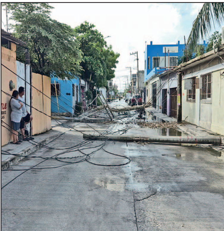
La zona es muy transitada y existe riesgo de accidentes. (I. Lozano)
