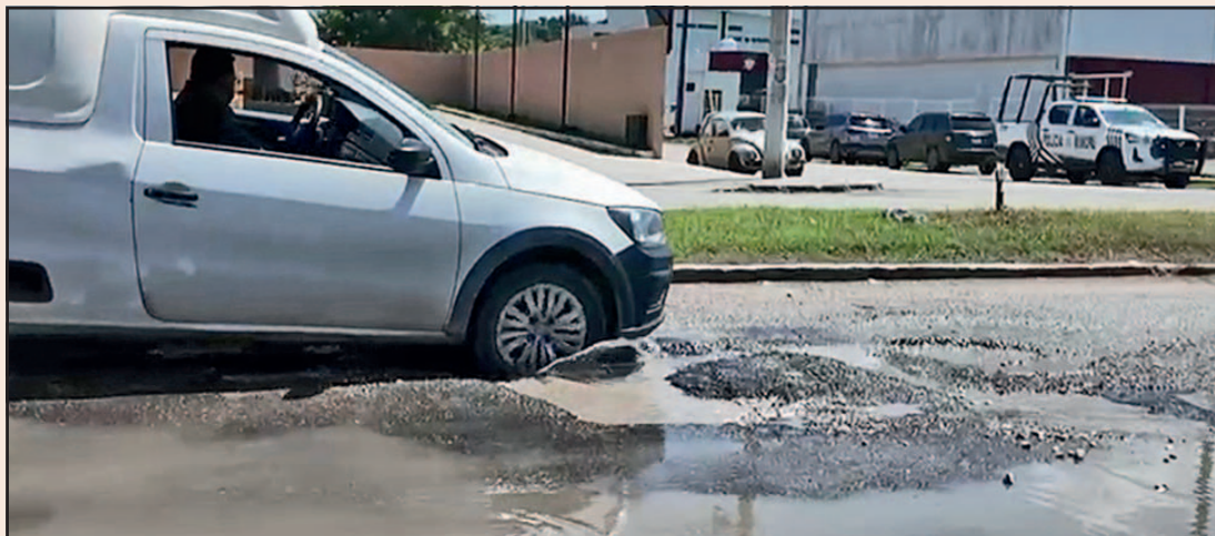
Prevén accidentes ya que los choferes deben maniobrar para evitar los hoyancos. (Jorge May)
