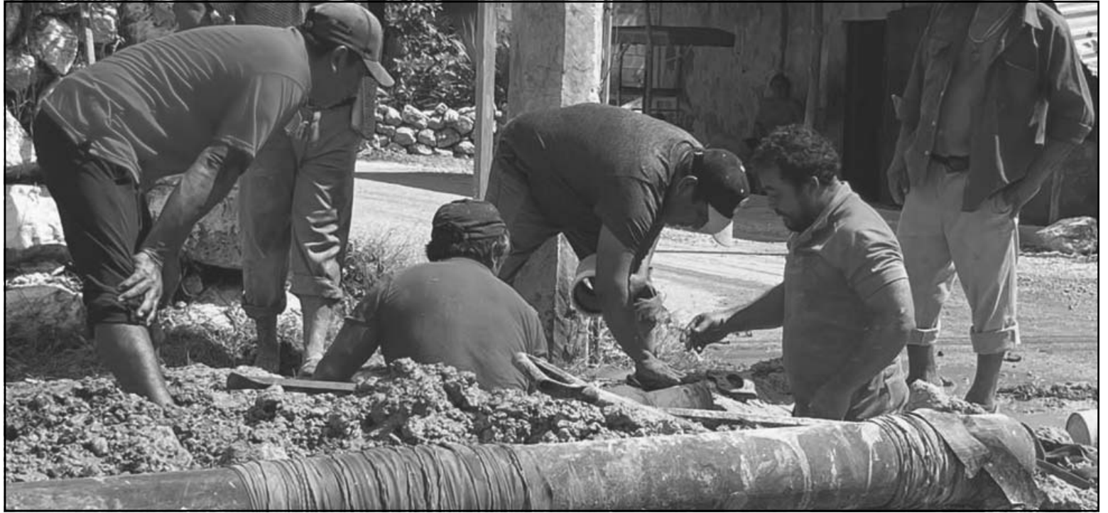
Las constantes fugas en la calle 20 por 21 obligaron a sustituir la red deteriorada, que afectaba el servicio y las condiciones de la vialidad.
