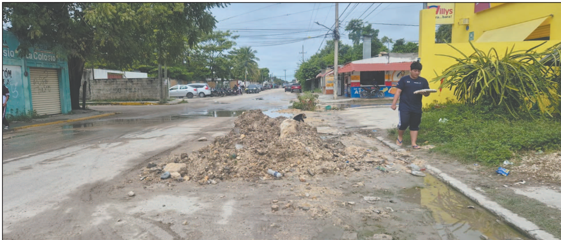
Los habitantes y comerciantes de la colonia La Cruz reportan molestias por la lentitud de los trabajos y las complicaciones para circular y estacionarse. (Jorge May)
