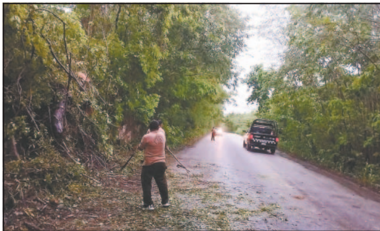
Personal municipal retiró vegetación antes y durante el aguacero.
