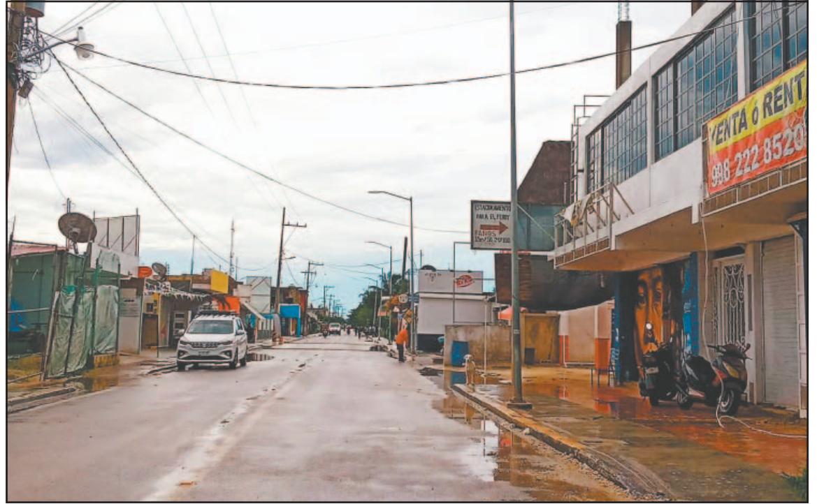
El encargado de la paraestatal justificó que se desprendió un cable de protección del tendido. (E. Cauich)
