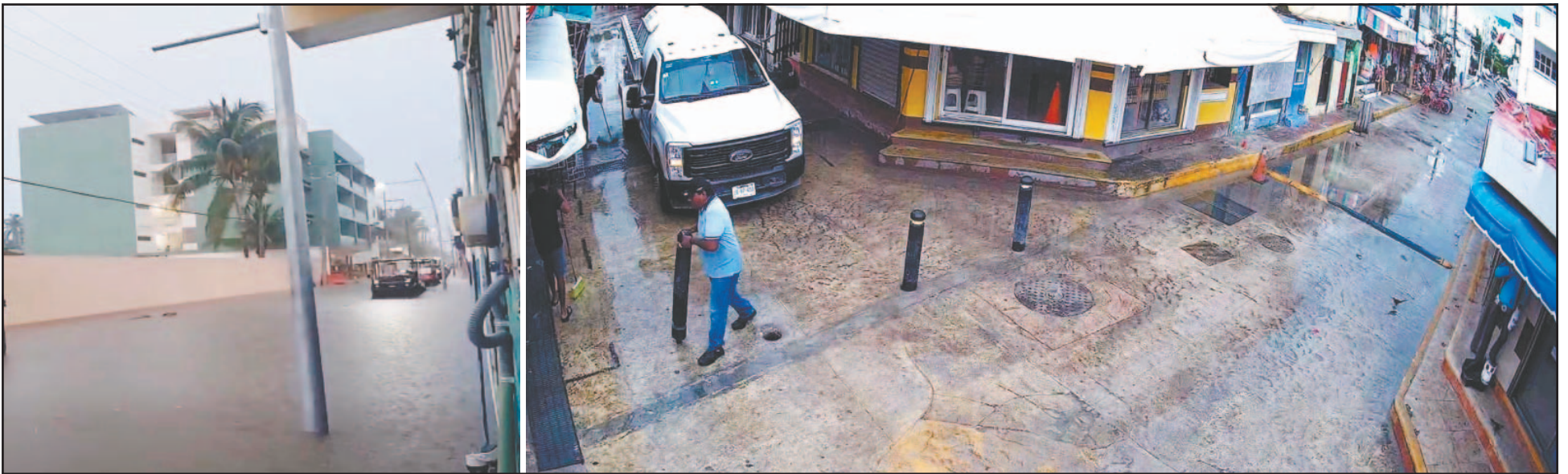
Los establecimientos resultaron afectados por las recientes precipitaciones; el sistema de bombeo instalado cerca de la Casa de la Cultura resulta insuficiente. (O. López)
