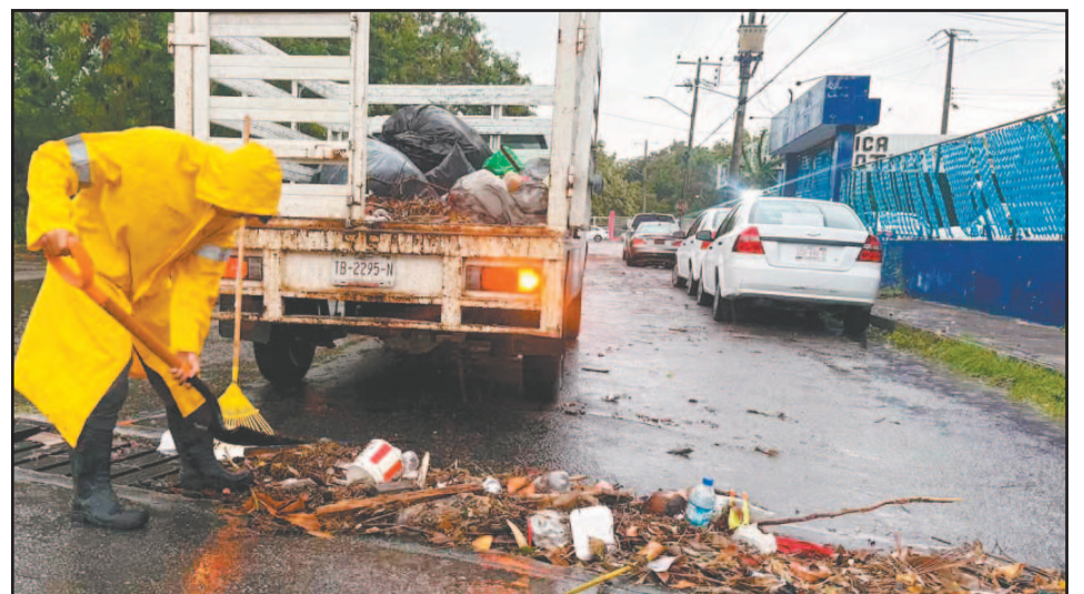
Bolsas y material vegetal impidieron el rápido desagüe del agua pluvial. (Efrén Baeza)
