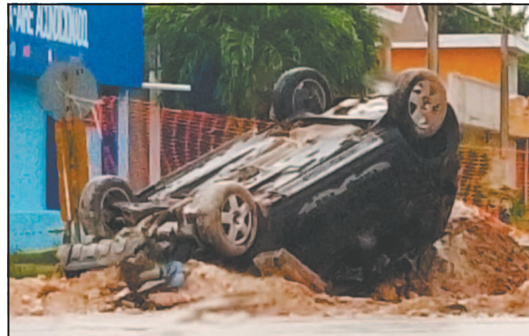
En Chetumal, un automovilista acabó en una obra de drenaje. (F. Baeza)
