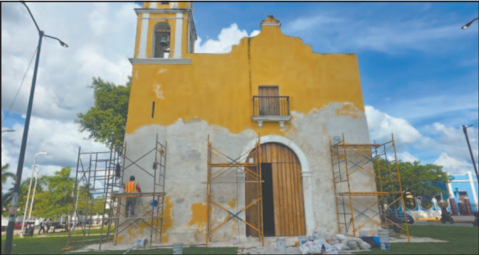
El inmueble guadalupano ya terminó una primera fase de rehabilitación en el interior.
