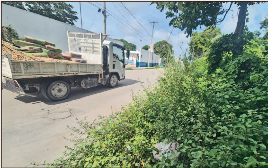
El problema se ubica en la calle 13 entre 24 y 26 y representa un añejo pendiente. (Jorge May Sosa)
