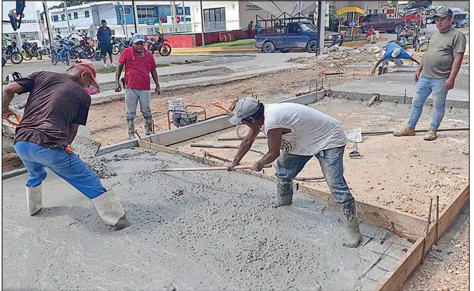
Las cuadrillas se concentran en los primeros 100 metros de esta arteria considerada dentro de un plan de ordenamiento vial. (POR ESTO!)
