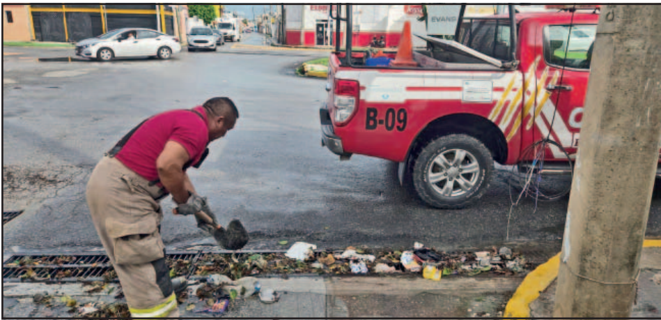
El mal tiempo evidenció una gran cantidad de basura en las alcantarillas y desagües.
