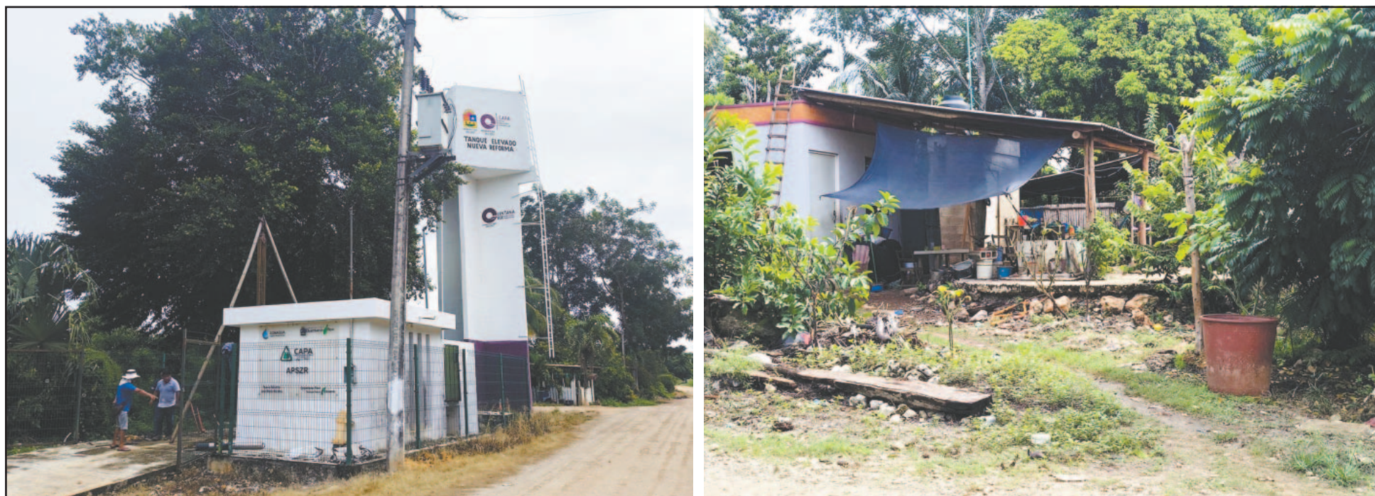
La CAPA distribuye el líquido mediante una pipa, mientras técnicos instalan un nuevo equipo, presuntamente dañado por falla en la red de la CFE, desde el pasado viernes. (L. Kauil)
